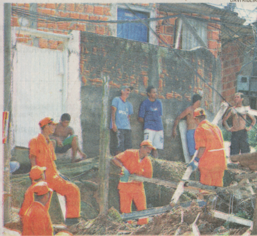
Trabalho de demolição das casas do morro terá de ser todo braçal
