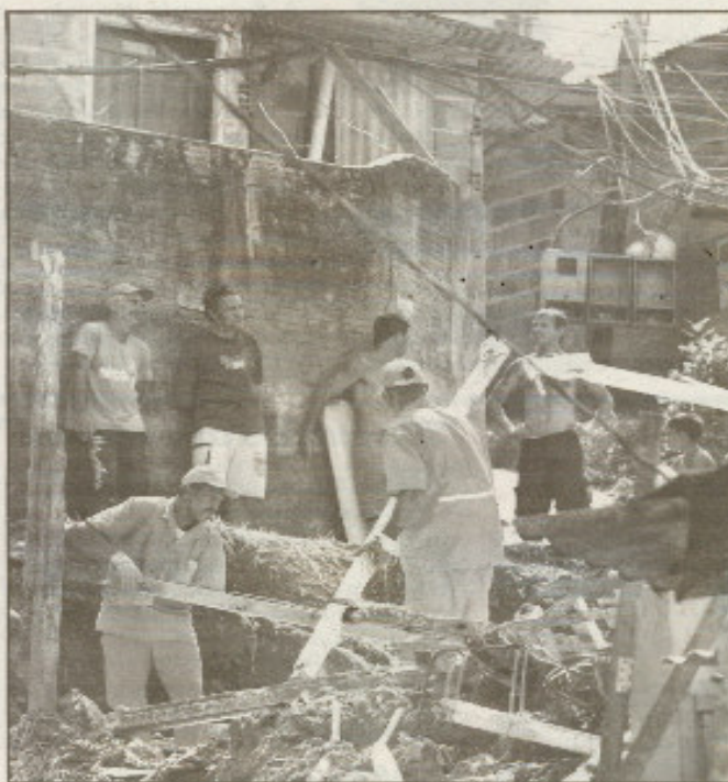
Demolição das moradias começou ontem e deve durar até um mês para acabar
